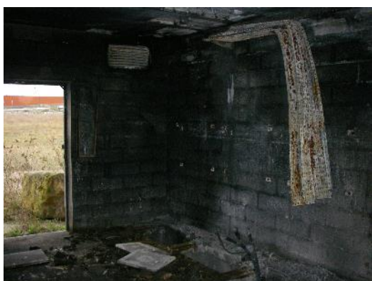
Vue n°17 : intérieur de l'ancien local poste transformateur électrique incendié
